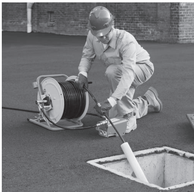
Figura 10 – Extinderea deschizăturii canalului la punctul de lucru
