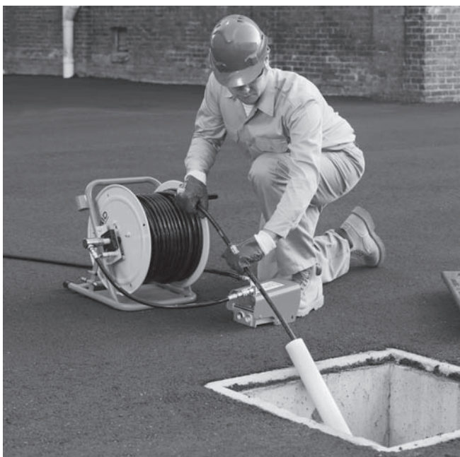
10. ábra – A lefolyónyílás meghosszabbítása az üzemeltetési ponthoz
