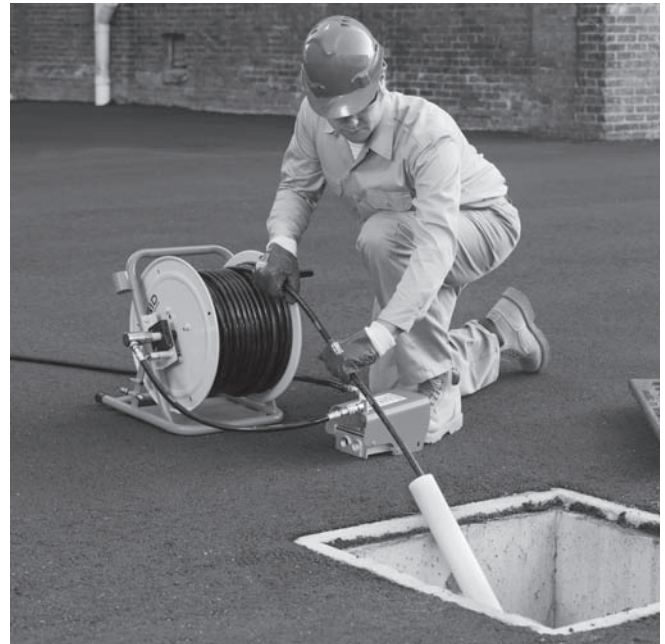
Rysunek 10 – Przedłużenie odpływu do punktu roboczego
