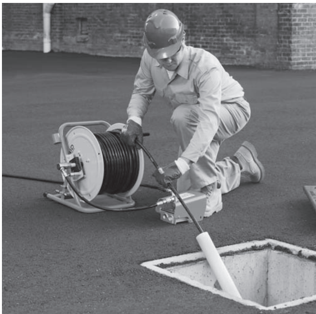
Slika 10 – Produžetak otvora odvoda do mesta rada
