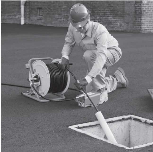
Figur 10 – Förlängning med rörledning till arbetspunkten
