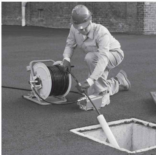
Kuva 10 – Viemäriaukon jatkaminen käyttöpisteeseen
